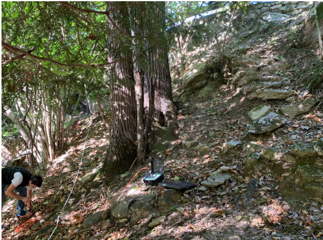
Stendimento sismico a rifrazione e MASW in corrispondenza dell'edificio che ospiterà la centrale di produzione
